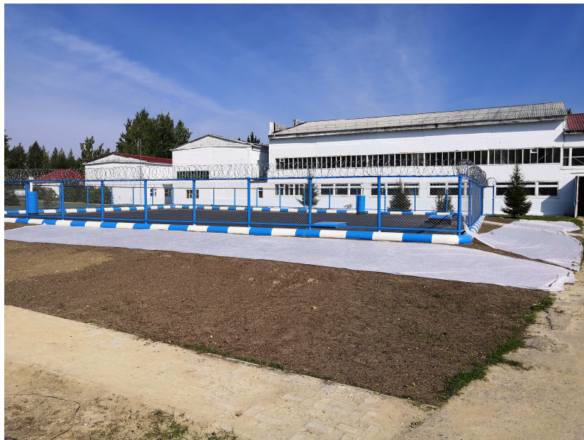
Рисунок 1.5 – Общий вид подземного резервуара питьевой воды
